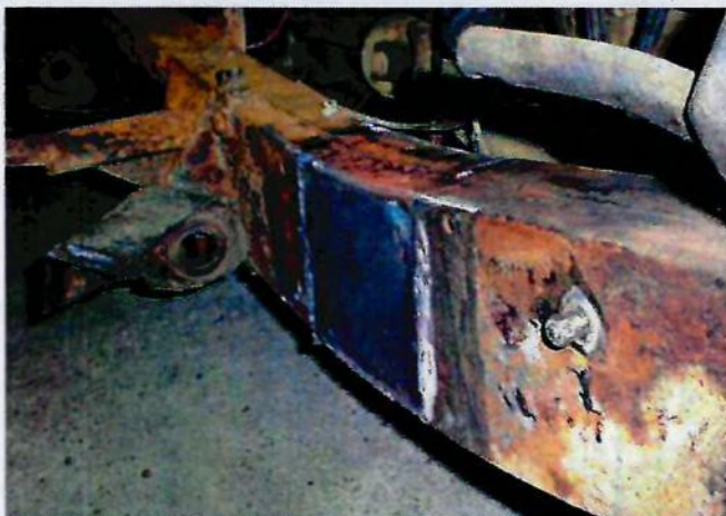
Коррозия сварного аутригера крана
